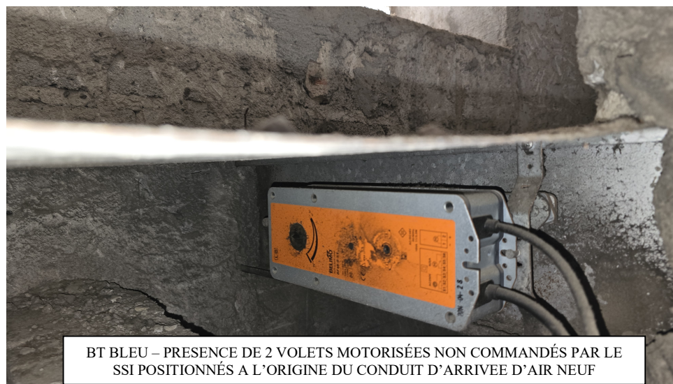
BT BLEU - R-2 – SALLE DE RESTAURANT AMMENÉES D'AIR NEUF REGROUPEES – BALAYAGE INSUFFISANT
