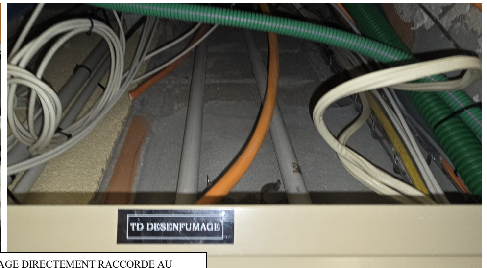
BAT BLEU - R+5 - TD DESENFUMAGE DIRECTEMENT RACCORDE AU TABLEAU PRINCIPAL DU BÂTIMENT
