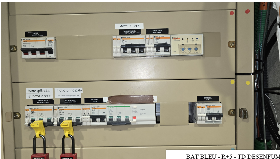
BAT BLEU - R+5 - TD DESENFUMAGE DIRECTEMENT RACCORDE AU TABLEAU PRINCIPAL DU BÂTIMENT
